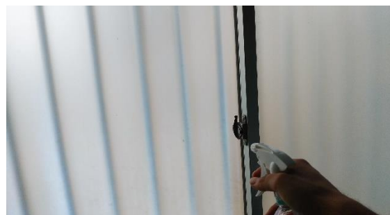
体育館トイレの窓の鍵
