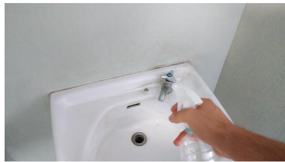
体育館トイレ内 水道
